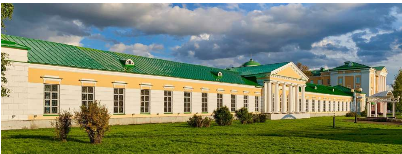
Рис. 4. Западный фасад арсенала
