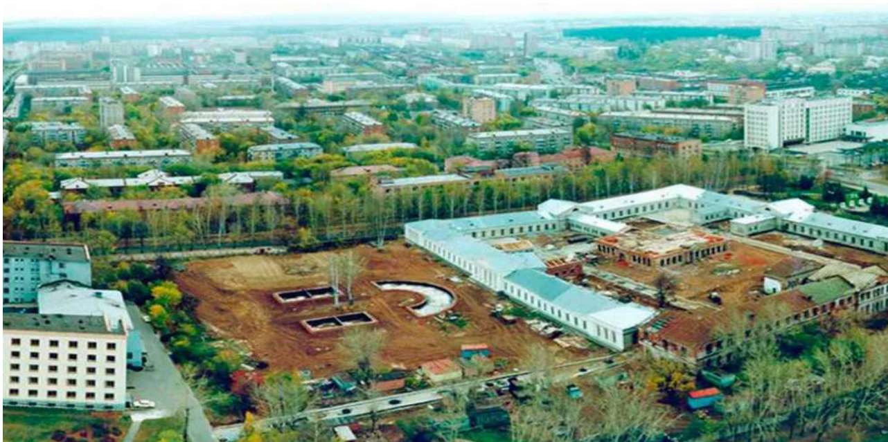
Рис. 3. Начало реставрации комплекса арсенала.
